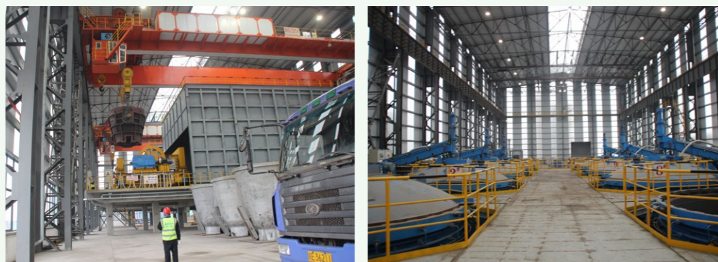
© 长江钢铁年处理 60 万吨钢渣项目建设
